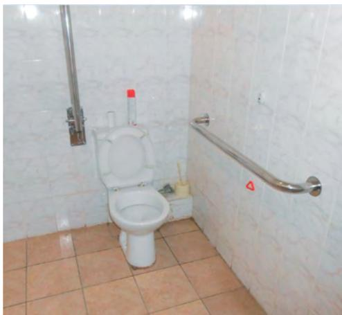
*Рисунок 5.7. Унитаз установлен в углу туалетной комнаты и оснащён горизонтальным стационарным поручнем (у стены) и откидным (со стороны подъезда кресла-коляски).*
