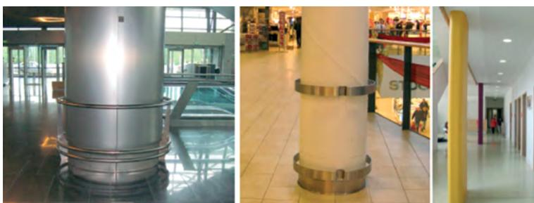
Рисунок 3.6. Примеры ограждения и/или контрастного обозначения колонн.
