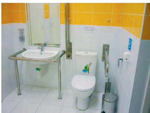
*Рисунок 5.9. Унитаз и раковина ошибочно размещены на одной стене, что делает невозможным подъезд к унитазу на кресле-коляске (Центр социальной защиты населения по Ленинскому району Волгоградской области).*
