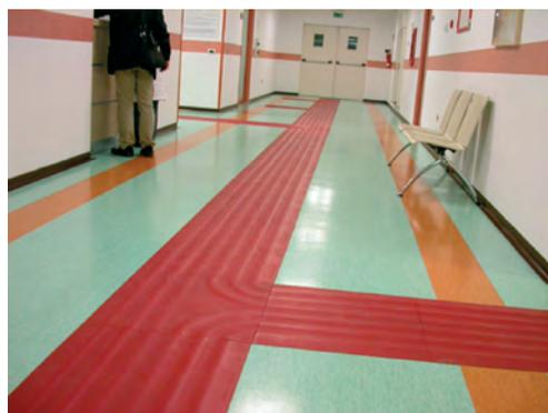
Рисунок 3.9. Примеры тактильных направляющих указателей на путях движения МГН.
