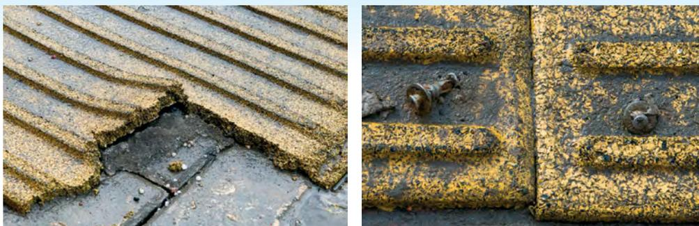
Рисунок 1.22. Проблемы, возникающие при использовании указатели тактильные из резинополиуретана.
