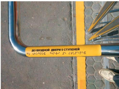
Рисунок 2.45. Контрастное обозначение части поручня.
