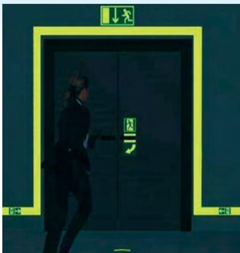
Рисунок 3.11. Использование светонакопительной ленты на путях эвакуации.
