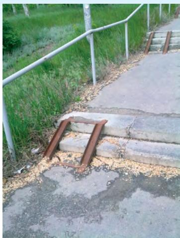
Рисунок 2.38. Ненормативный пандус, опасный для незрячих и слабовидящих, находится на пути от остановки скоростного трамвая «Водоотстой».
