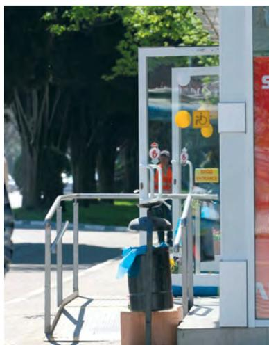
Рисунок 2.34. Препятствия в виде урны и цветочного вазона не позволяют пользоваться пандусом.
