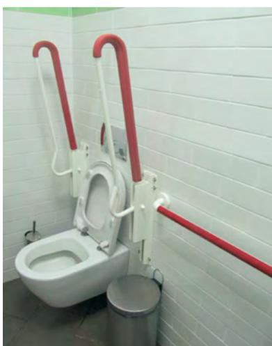
*Рисунок 5.12. Унитаз установлен консольно и оснащён откидными поручнями по бокам.*
