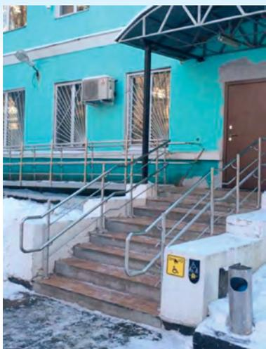
Рисунок 2.42. Лестница при входе в здание, оборудованная поручнями на высоте 50 и 90 см.
