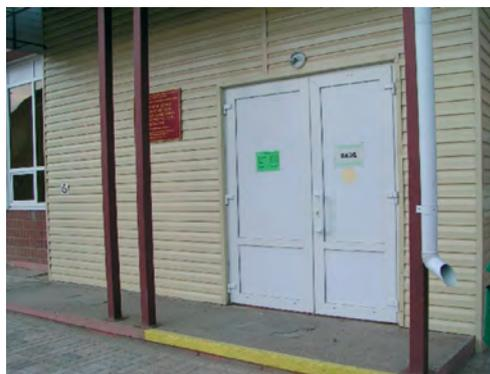
Рисунок 2.7. Плита перед входной дверью Центра социальной защиты населения г. Камышин Волгоградской области затрудняет движение МГН, особенно инвалидов-колясочников.
