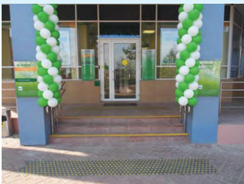
Рисунок 2.9. Пример применения тактильных указателей у входа в здание.
