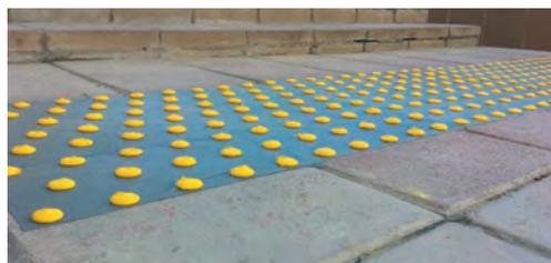
Рисунок 1.27. Пример моделирования тактильных указателей из холодного пластика.
