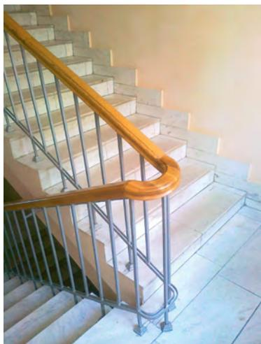
Рисунок 2.46. Пример непрерывного исполнения поручня вдоль лестницы и между маршами лестницы.
