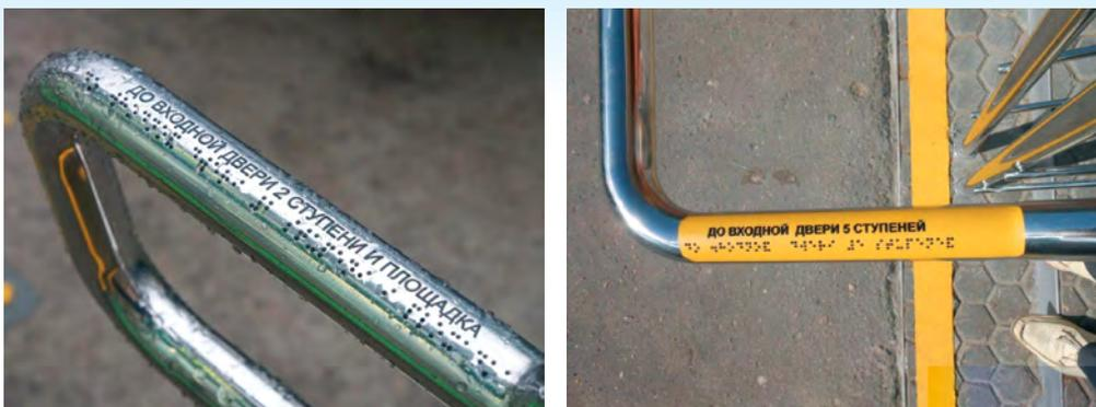
Рисунок 6.18. Информация рельефно-точечным шрифтом Брайля и тактильными буквами на поручнях лестниц.
