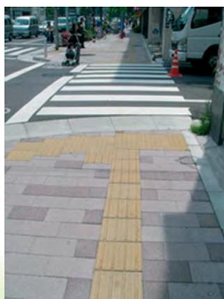
Рисунок 1.17. Тактильная направляющая к пешеходному переходу.
